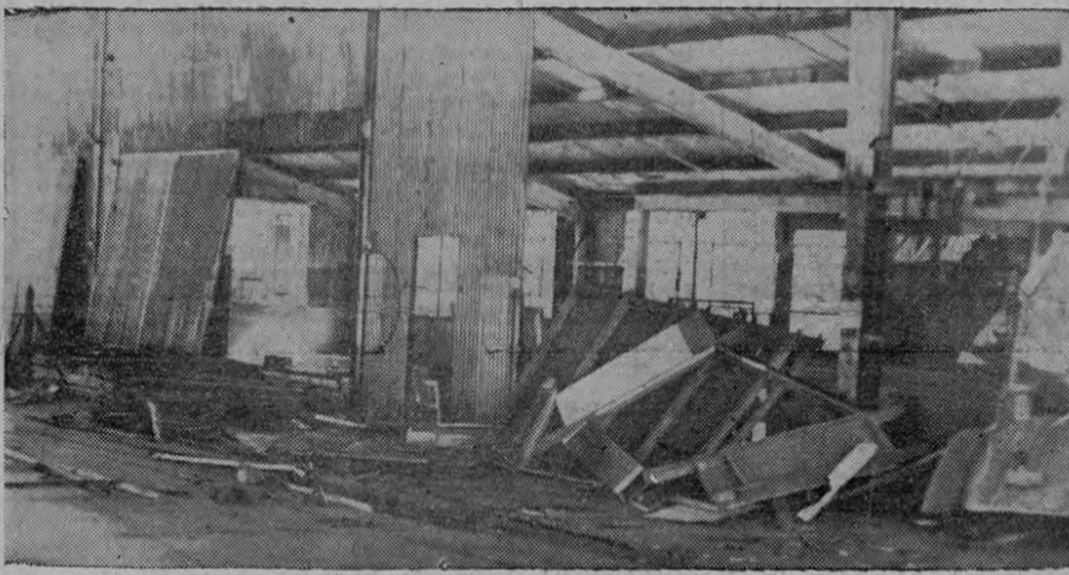
Este era el antiguo taller de SALA, donde se han iniciado los trabajos para hacer una escuela, que tendrá más de 20 aulas. Como se aprecia en la foto, el esfuerzo por hacer la conversión va adelantando.—
